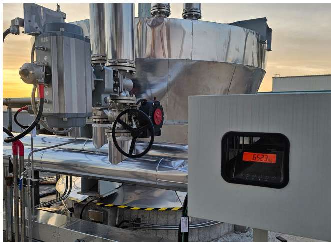
X2显示器与客户的DCS系统集成，实现进出料阀门的自动化控制
